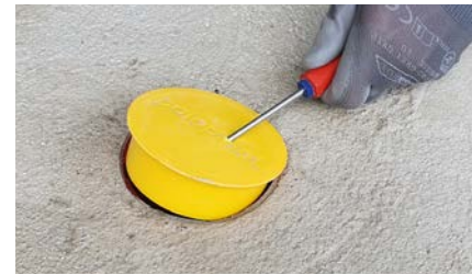
Bauschutzdeckel entfernen
