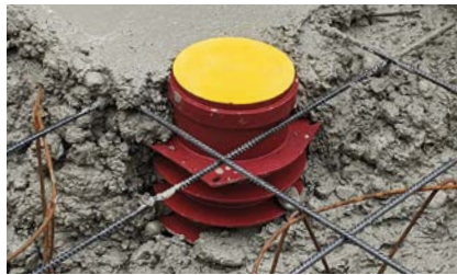
Betonieren und rütteln
